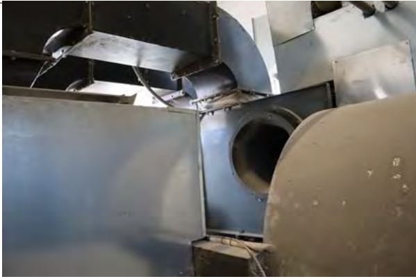
Ventilator sa kanalima je u funkciji. Potrebna zamjena temperaturnih osjetnika.
