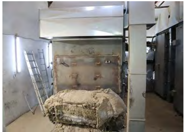
Neispravan / nekompletan. Potrebna zamjena neispravnih cijevi kotla. Potrebno je izoliranje kotla.
