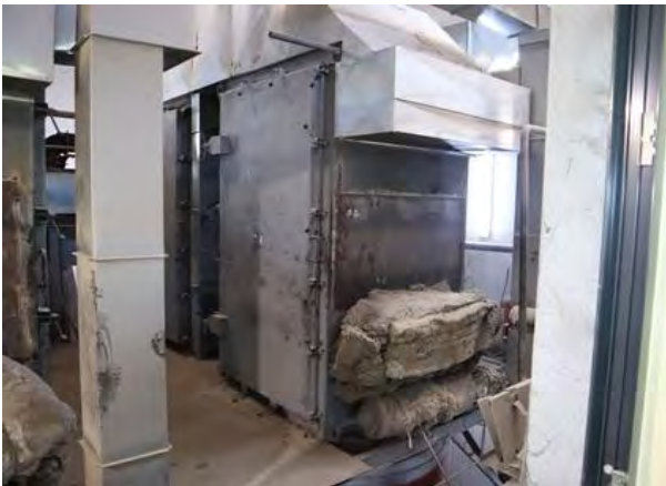
Neispravan / nekompletan. Potrebna zamjena neispravnih cijevi kotla. Potrebno je izoliranje kotla.
