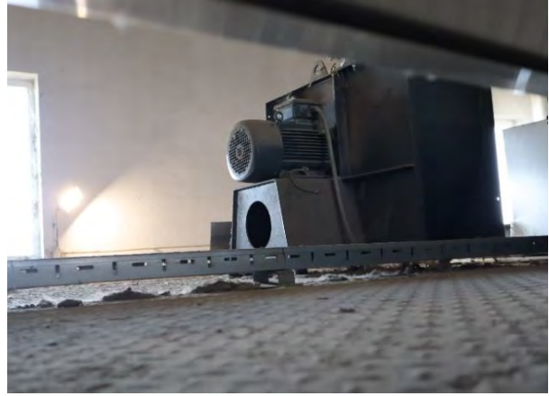
Ventilator sa kanalima je u funkciji. Potrebna zamjena temperaturnih osjetnika.
